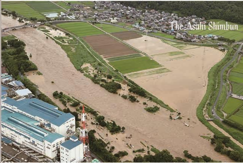
▲2022年8月5日午前9時、滋賀県長浜市の高時川流域で田んぼや河川敷が浸水しているようす。 「洪水」のように見えるが、これは霞堤によって制御された氾濫。浸水しているのは当初から氾濫が想定されている遊水池となる場所。さらに、堤防として機能させることを想定して作られている道路もしっかりと集落への浸水を防いでいる。 (撮影：朝日新聞映像報道部、解説：@Kent AOKIさん on Twitter)
