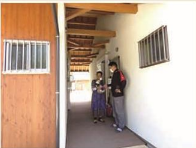
▲馬立団地の住居間には『通り土間』が設けられ、隣家の音を遮り、雨風をしのぐ空間にもなっている。設計から建設まで事業者グループが担い、完成後に村が買い取る「買い取り型」の復興住宅である。
