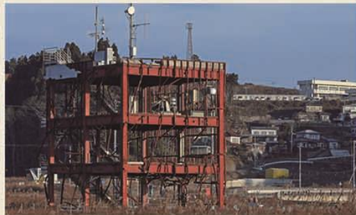
【保存：南三陸町防災対策庁舎】鉄骨3階、高さ12メートル。東日本大震災で15.5メートルの津波に襲われ、骨組みだけが残った。佐藤仁町長は2013年9月、町単独では保存経費が重荷になることなどを理由に解体を表明。同年12月、県が震災遺構有識者会議の検討対象に防災庁舎を加え、解体は実質的に保留されている。現在は施設、土地ともに南三陸町が所有している。(「すけさきた」2015年2月に掲載)
