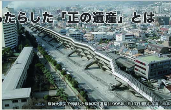
阪神大震災で倒壊した阪神高速道路(1995年1月17日撮影)写真/時事
